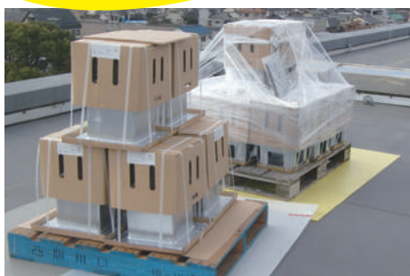
工場生産品を設置
