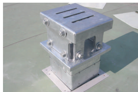
③mm単位で高さ・水平調整後、完了
