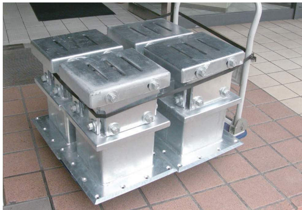
バルベースA/外アンカーを搬入。(写真は台車を利用)
