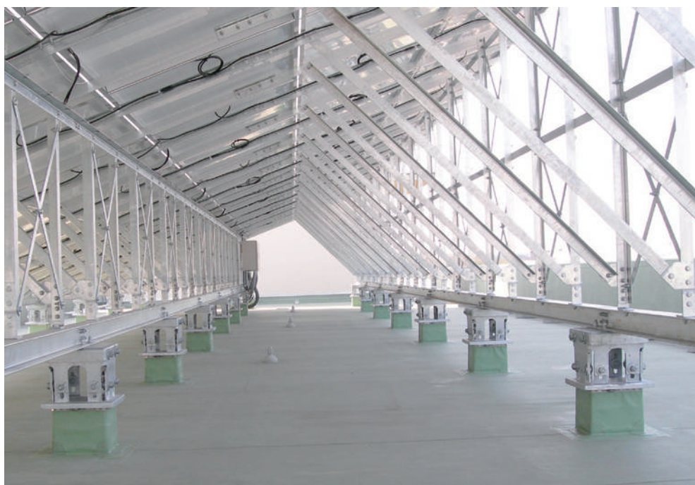
ソーラーパネル設置工事:ソーラーパネルの設置完了。
