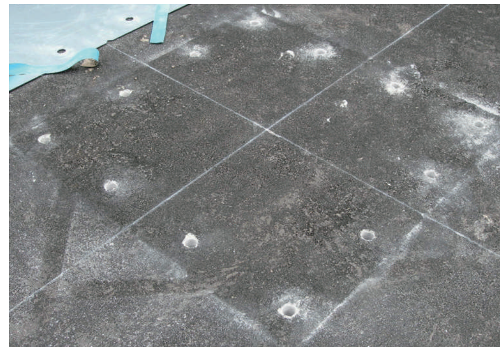
1基につき12箇所穿孔する。
