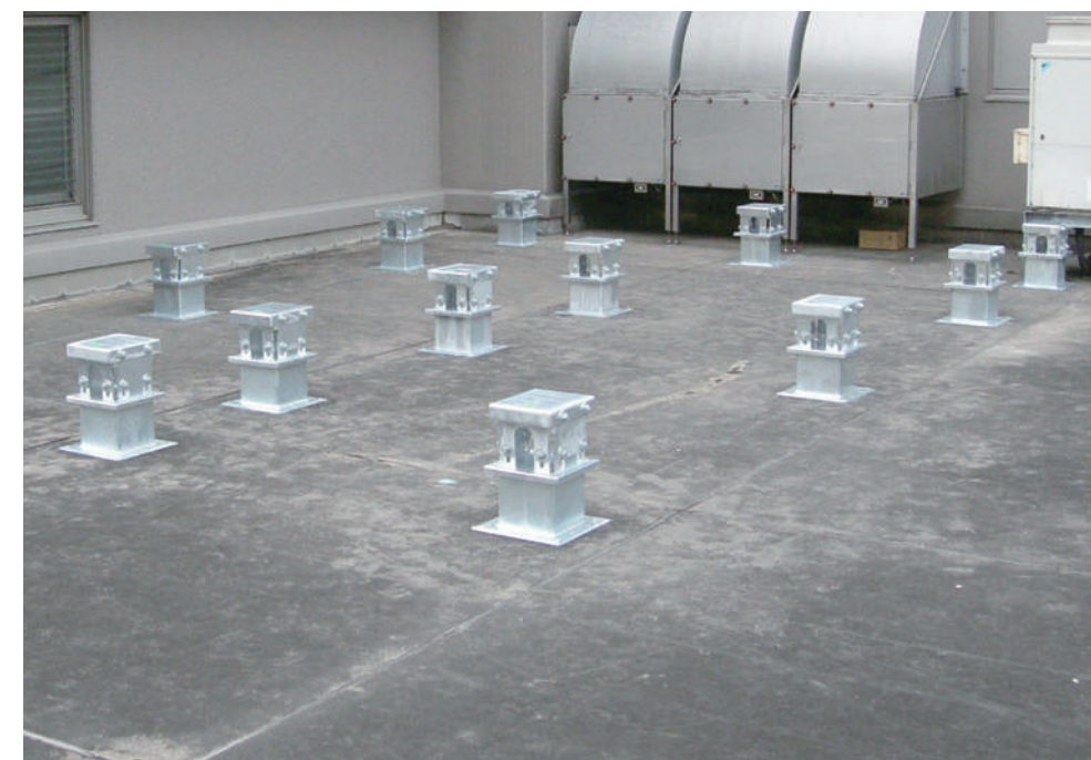
1日で13個のベルベースA/外アンカーを設置完了。
