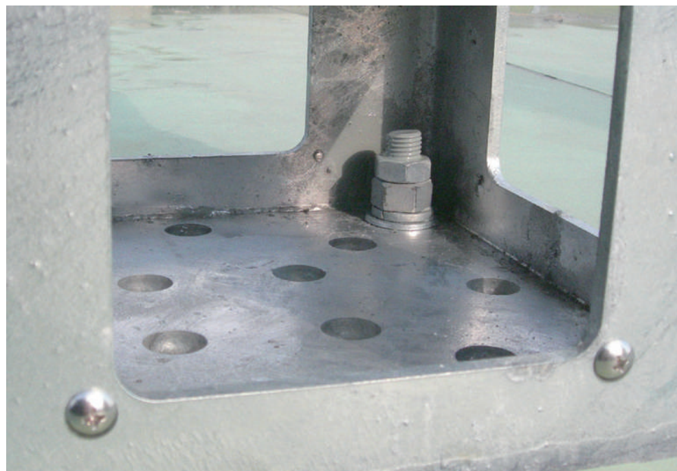
アンカーボルトによるベルベースの固定完了。
