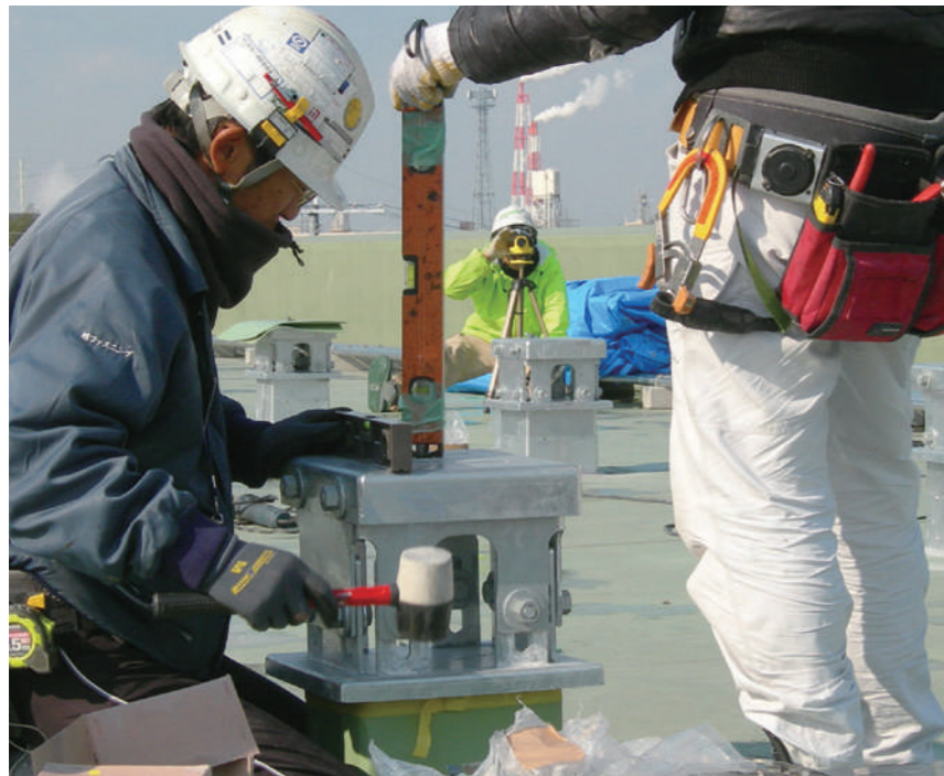
⑤頭部高さ及び勾配を調整。(調整ボルトを仮締めし、レベル等に合わせて四隅を樹脂ハンマーで軽く叩く)
